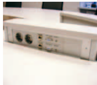
Versenkbare Anschlussfelder
